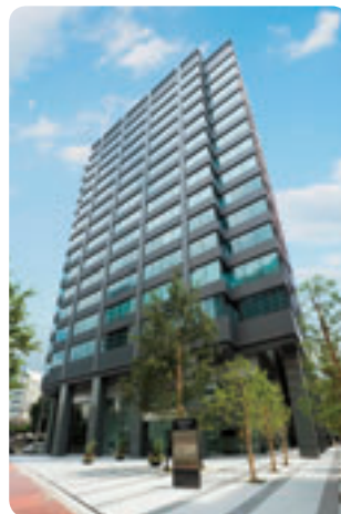
住友不動産九段ビル
