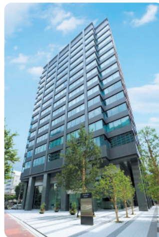
住友不動産九段ビル
